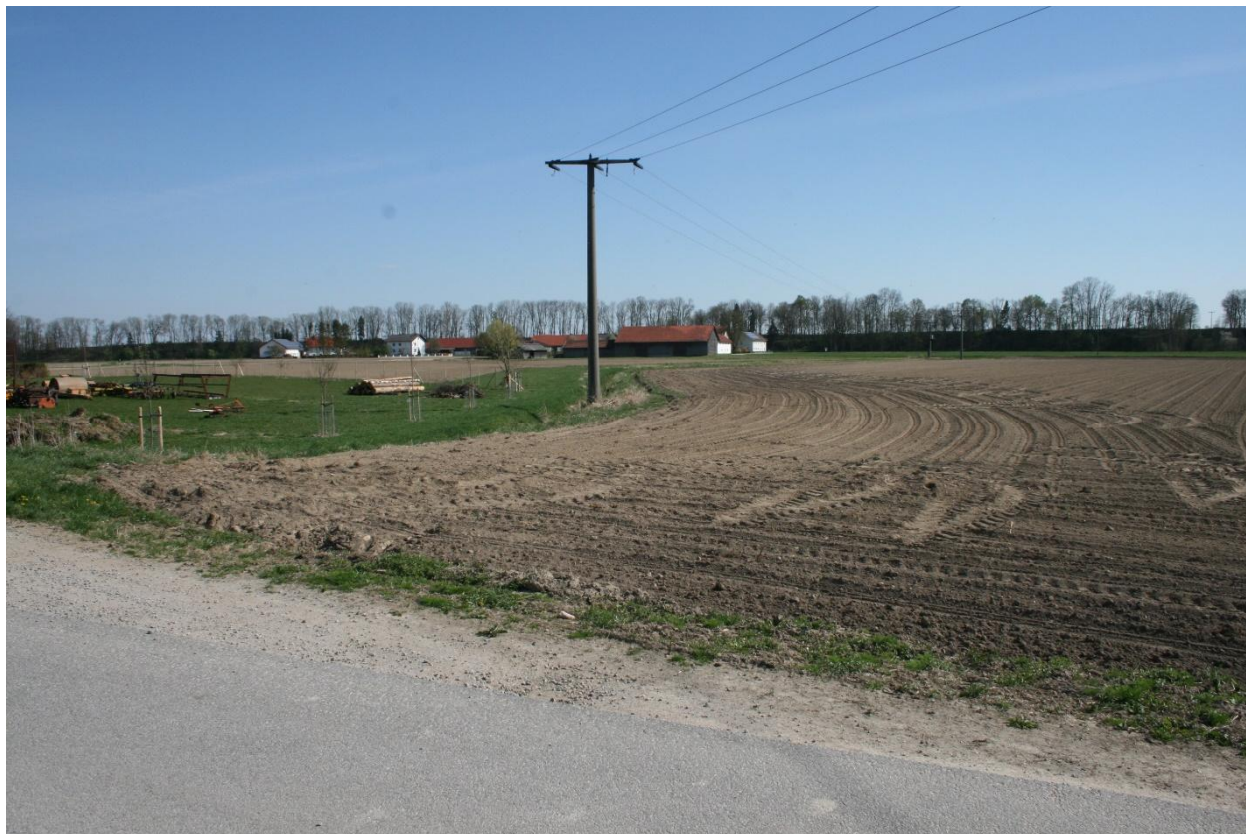
Blick nach Süden auf bestehende Mittelspannungsfreileitung, Eigenes Archiv 04/2022
