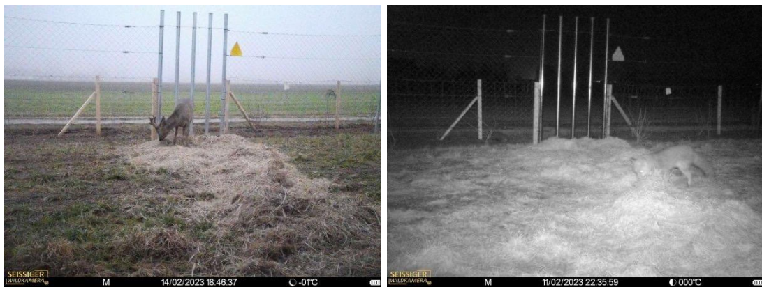
Wilddurchlässe in der Freiflächenphotovoltaikanlage „Burgstall West“
