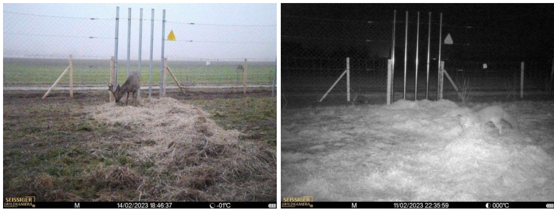
Wilddurchlässe in der Freiflächenphotovoltaikanlage „Burgstall West“
