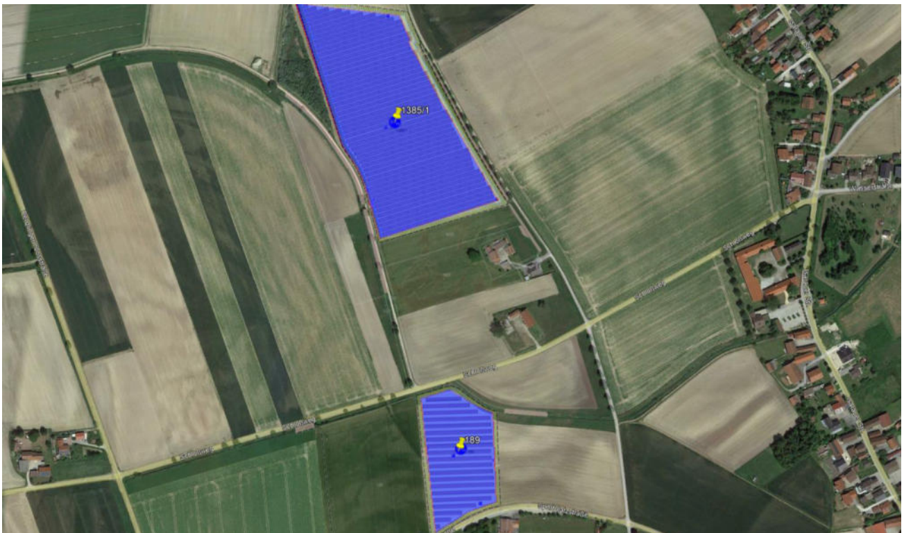
Bild 2.1.5. Detailansicht der PV-Fläche Teil West (Quelle: Google Earth/SolPEG)
