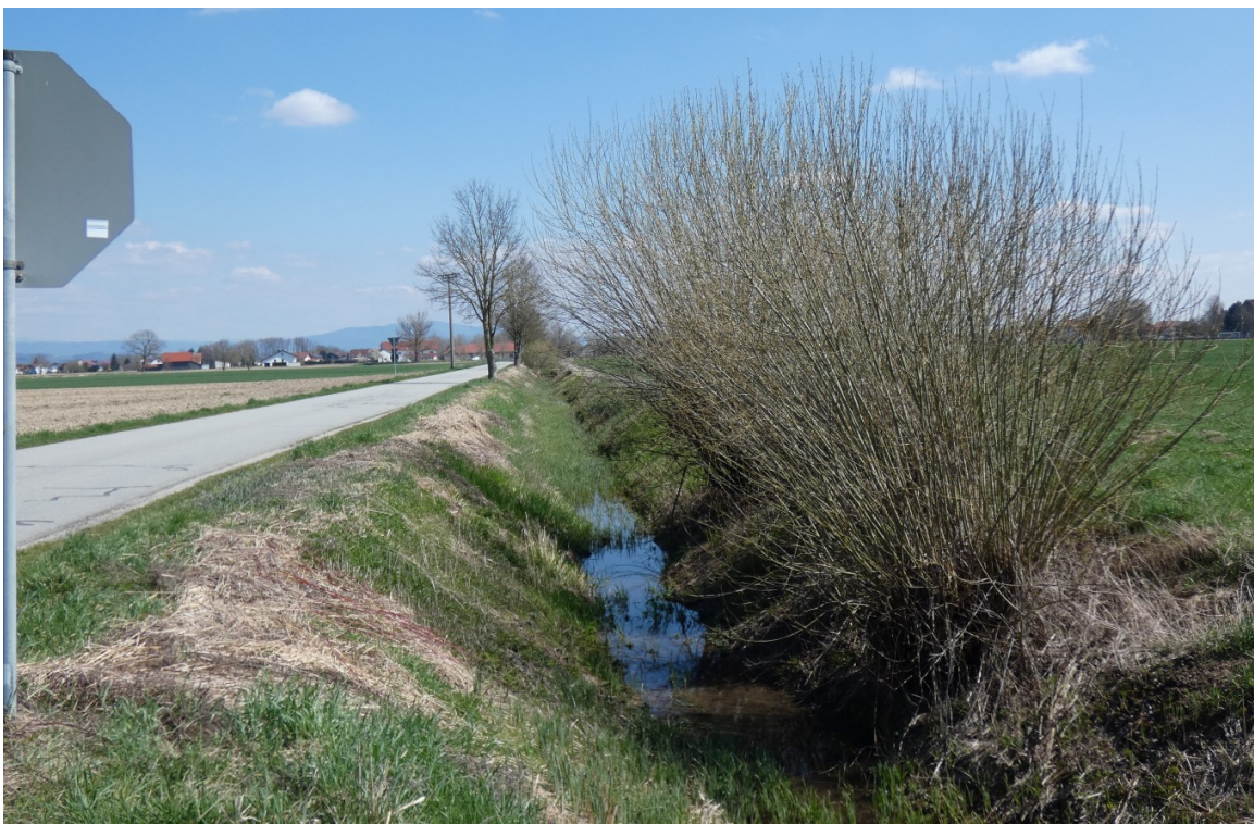
Abbildung 20: FI-Nr. 187 - Blick von West über vernässten Graben am nördlichen Rand von FI-Nr. 187 am 6.4.2023
