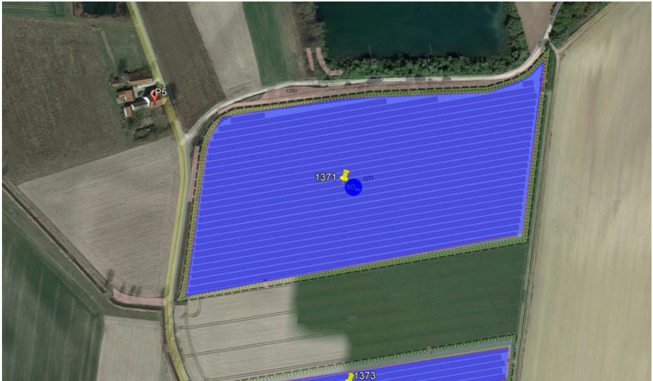
Bild 3.5.4: Übersicht über die PV-Anlage und die Messpunkte (Quelle: Google Earth/SolPEG)
