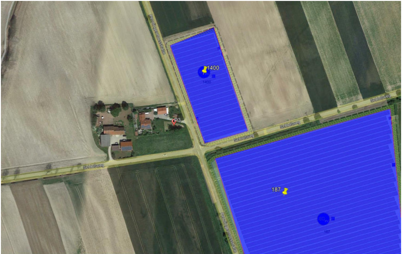
Bild 3.5.2: Übersicht über die PV-Anlage und Messpunkte (Quelle: Google Earth/SolPEG)
