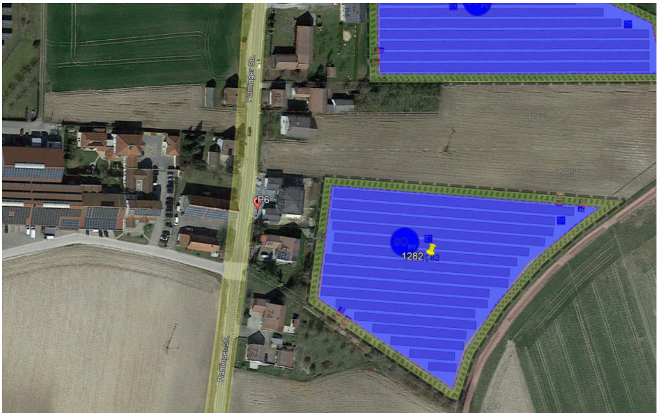
Bild 3.5.5: Übersicht über die PV-Anlage und die Messpunkte (Quelle: Google Earth/SolPEG)
