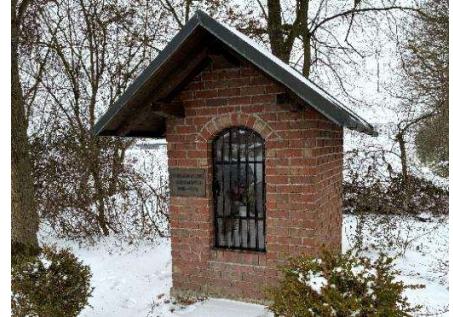
Schön steht sie da, die aus Ziegel gemauerte Flurreinigungskapelle
