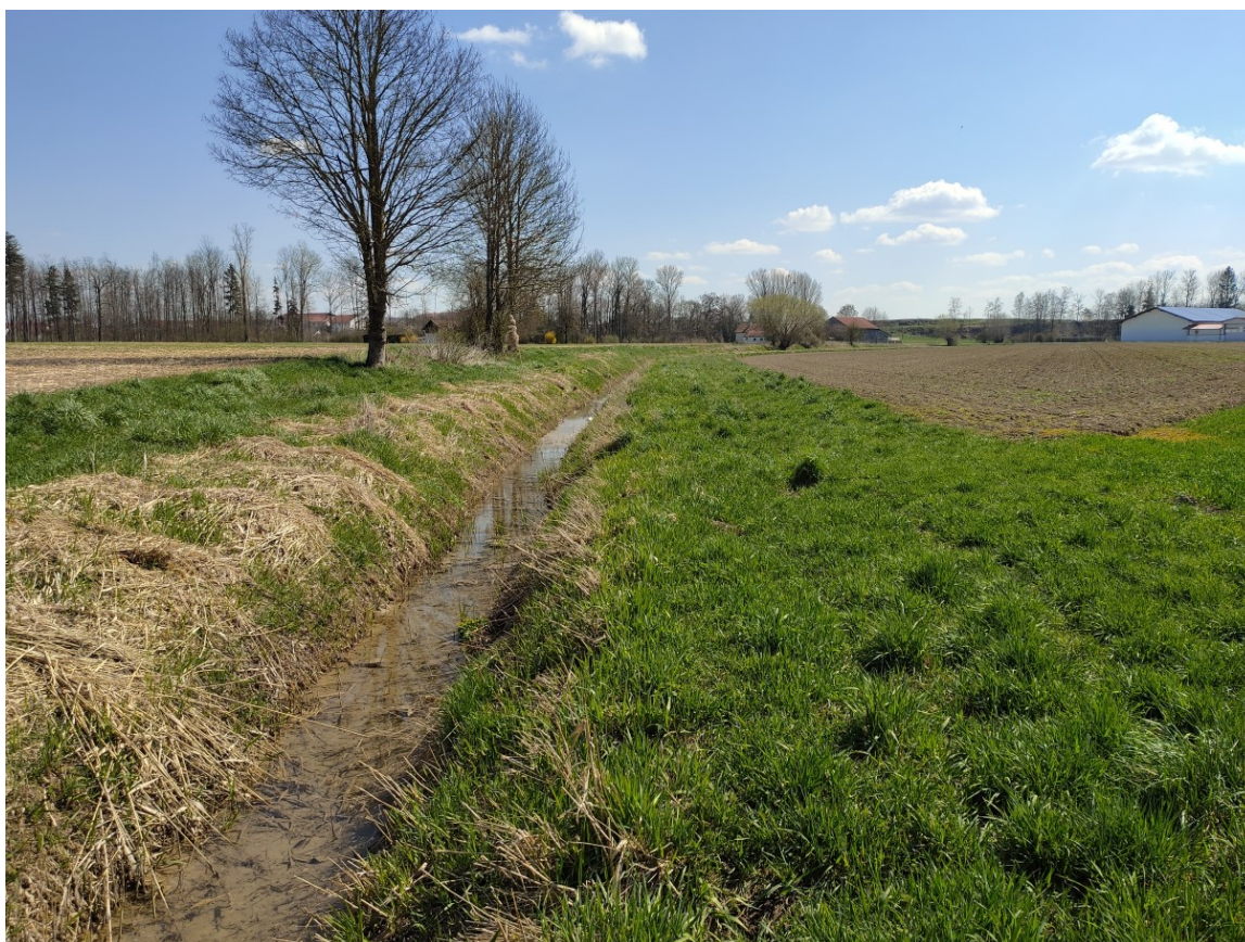
Abbildung 17: Blick von Nord entlang des tief eingeschnitten Grabens am Ostrand von FI-Nr. 4114 mit Gewässer-schutzstreifen am 6.4.2023
