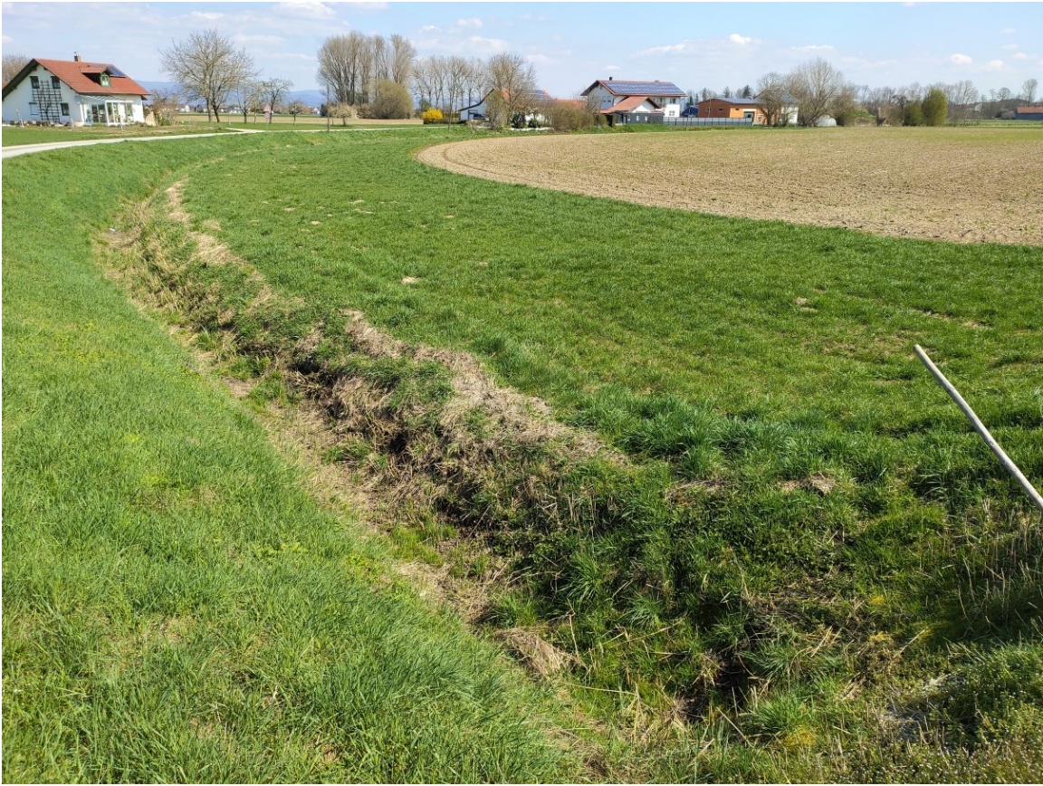
Abbildung 7: Blick von Südwest über nur noch an der Sohle leicht vernässten Graben mit breitem Gewässerschutzstreifen am Westrand von FI-Nr. 4103/5 am 6.4.2023
